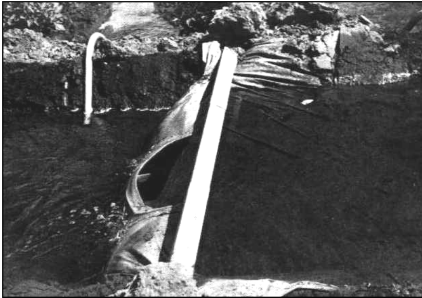
Gambar 2.15g. Bangunan kontrol muka air terbuat dari kanvas dapat dipindahkan
