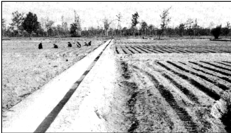
Gambar 2.15e. Saluran lapangan pada urugan dengan pelapisan
