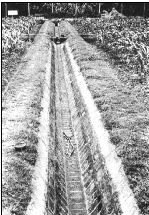
Gambar 2.15f. Saluran lapangan dengan pelapisan dan bangunan kontrol muka air di bagian hilir
